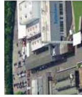
MBS Troisdorf Spicher Strasse 46-48 53859 Troisdorf Fon: +49 (2241) 481 720
